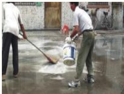
Очистка разбавленной соляной кислотой
