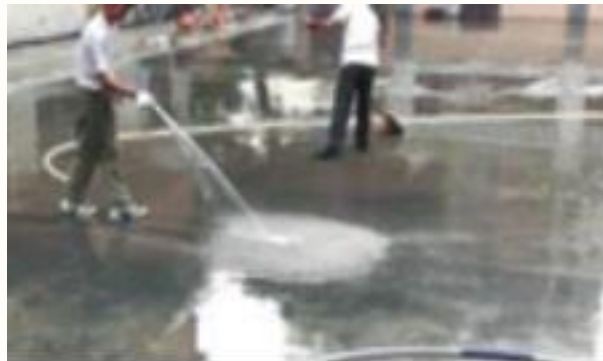
Удаление пыли водяным пистолетом высокого давления
