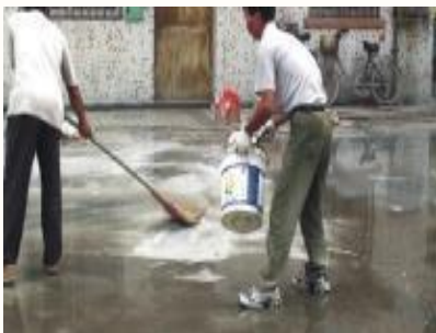
Очистка разбавленной соляной кислотой
