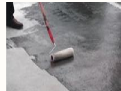
Нанесение грунтовки роликом
