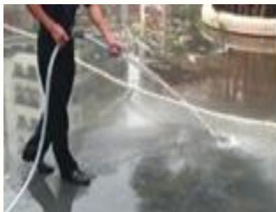
Очистка поверхности земли водой
