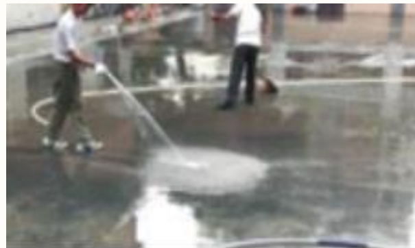
Удаление пыли водяным пистолетом высокого давления
