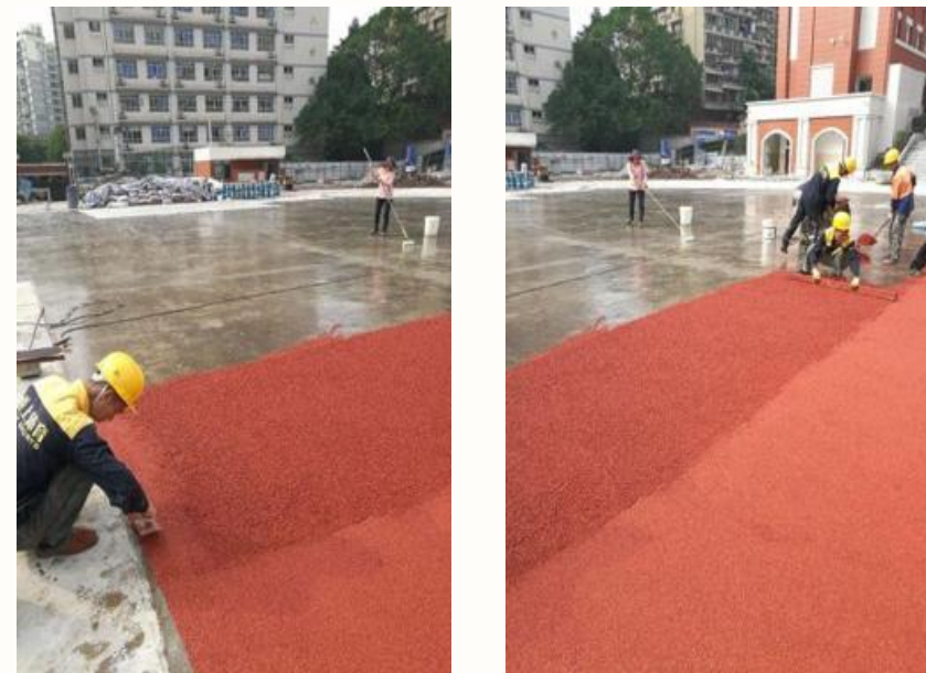
Ровная укладка эластичного слоя
