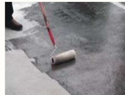
Нанесение грунтовки роликом
